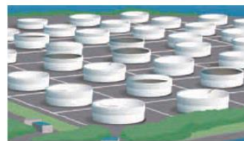
石油タンク・漏洩監視
